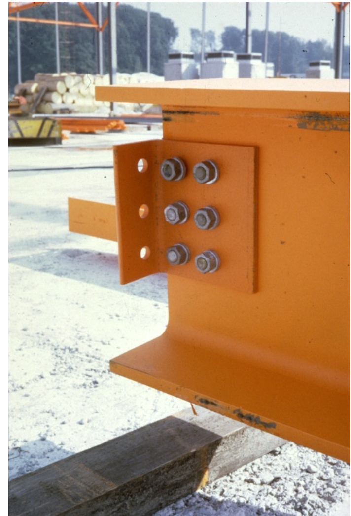
Figure 9.6 TGC 10: Transmission des efforts dans une liaison poutre-colonne réalisée à l'aide de deux cornières boulonnées.
