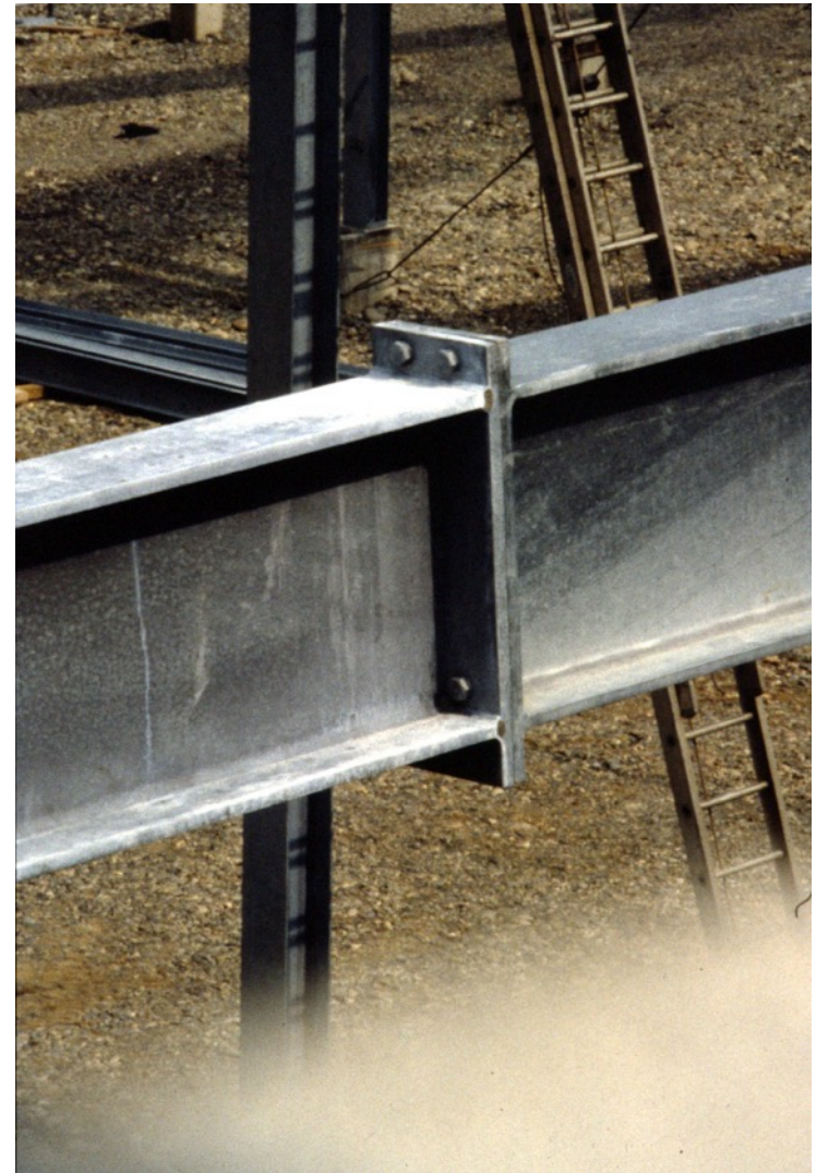
Figure 9.11 TGC 10: Joint de poutres boulonnés transmettant à la fois un moment de flexion et un effort tranchant.
